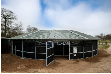
Umzäunung 15 meter Überdachung
