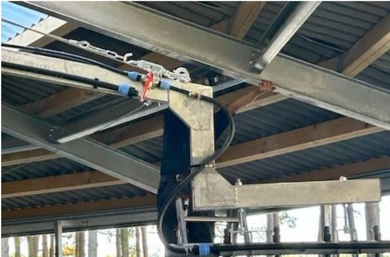
Die Longierpiste-Beregung hält den Longierring in der Führanlage feucht, damit beim Laufen der Pferde kein Staub aufgewirbelt wird. Die Beregung sorgt zudem für einen stabileren Boden.
