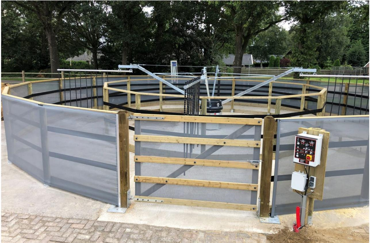
Windschutznetz um die Außenseite des Zauns. Das Windschutznetz wird an beiden Enden durch eine Spannrolle gespannt. Das Windschutznetz ist über die gesamte Länge gesäumt und rundum mit einem Clip gegen Durchhängen gesichert.
